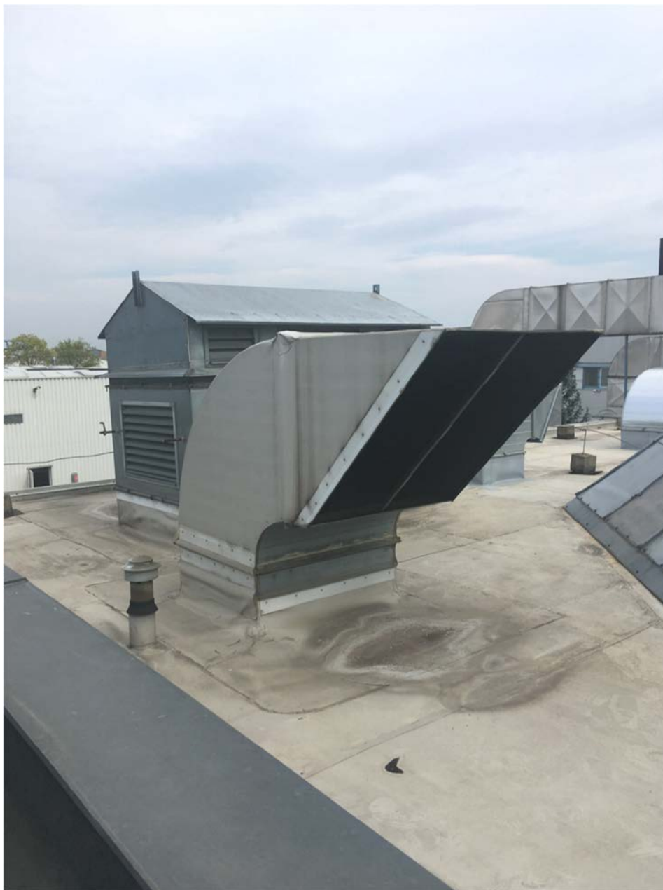
A sűrített levegő kifúvó kürtő (Puskás Tivadar utca 10. épület tetején)
