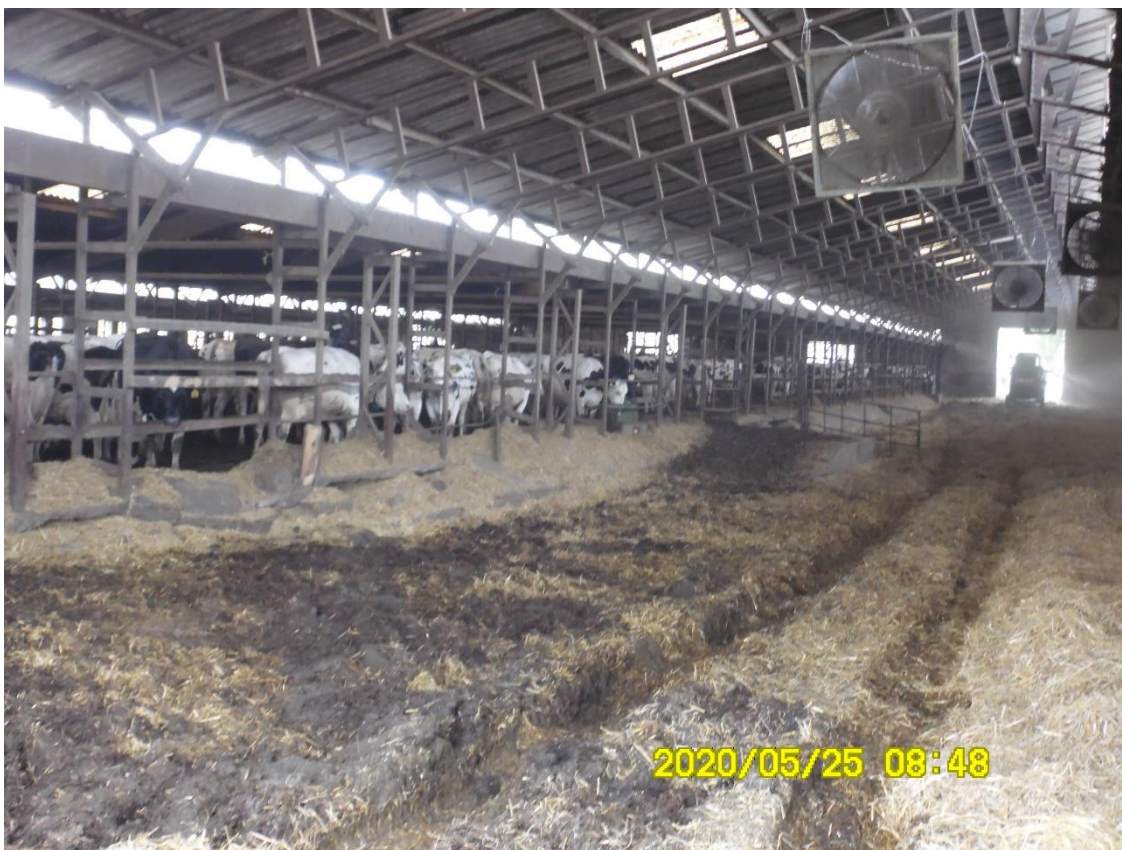
18.sz. kép – mélyalmos istálló ventilátorokkal
