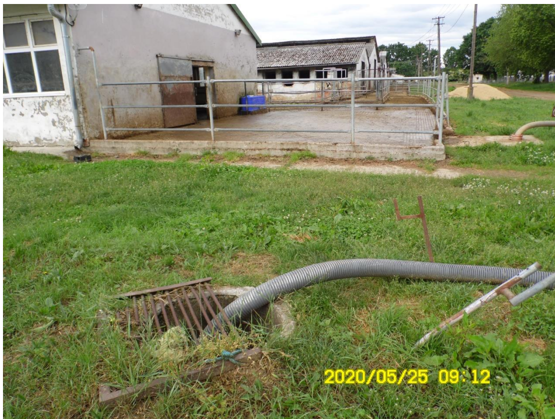
6.sz. kép – fejőház és gyűjtőaknái
