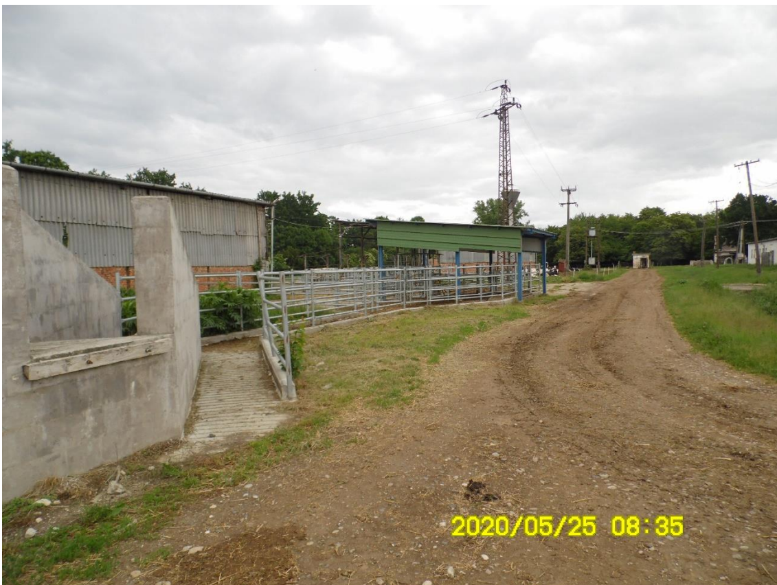
24.sz. kép – mérlegház felhajtóval
