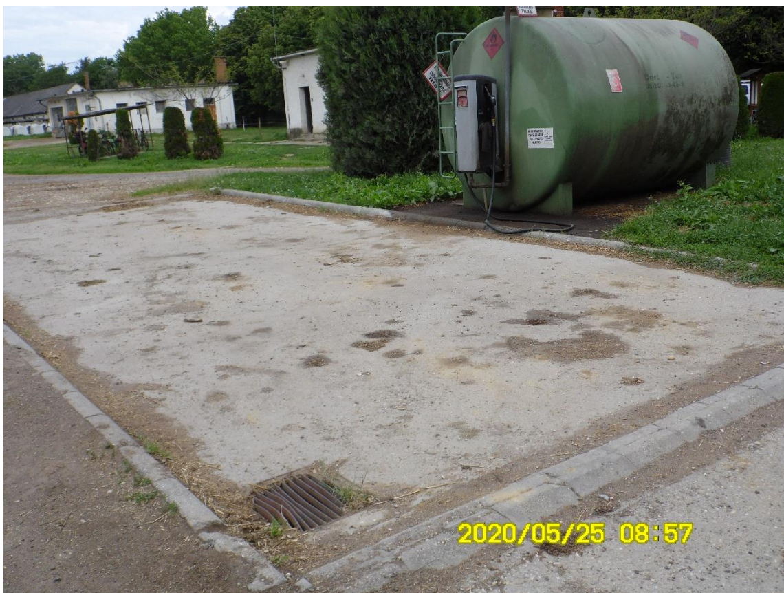
12.sz. kép - üzemanyag-tartály kiszolgáló automatával és kármentővel
