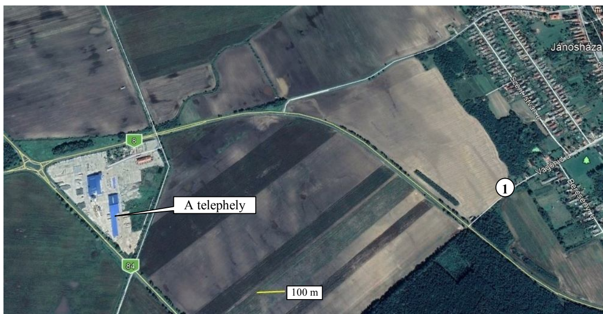
6.2 ábra A telephely és környezete műholdképen (GoogleEarth 2018.) – '1' a zajvizsgálati pont
